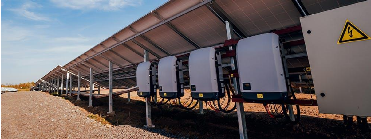
Slika 5. Primjer montaže invertera uz profine nosače konstrukcije
